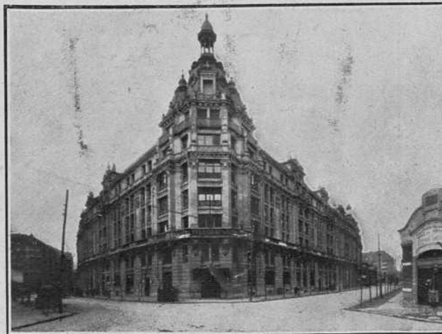
Manzana de casas, propiedad de la Caja de Ahorros Municipal de Bilbao Arquitecto: D. Ricardo de Bastida
