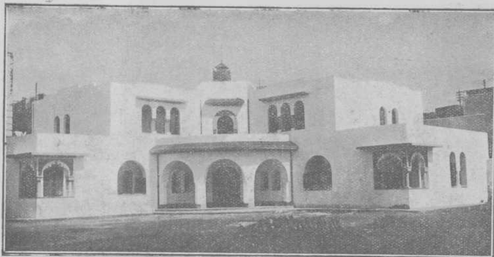
LARACHE - EDIFICIO DE FOMENTO Y DE CONSTRUCCIONES CIVILES
