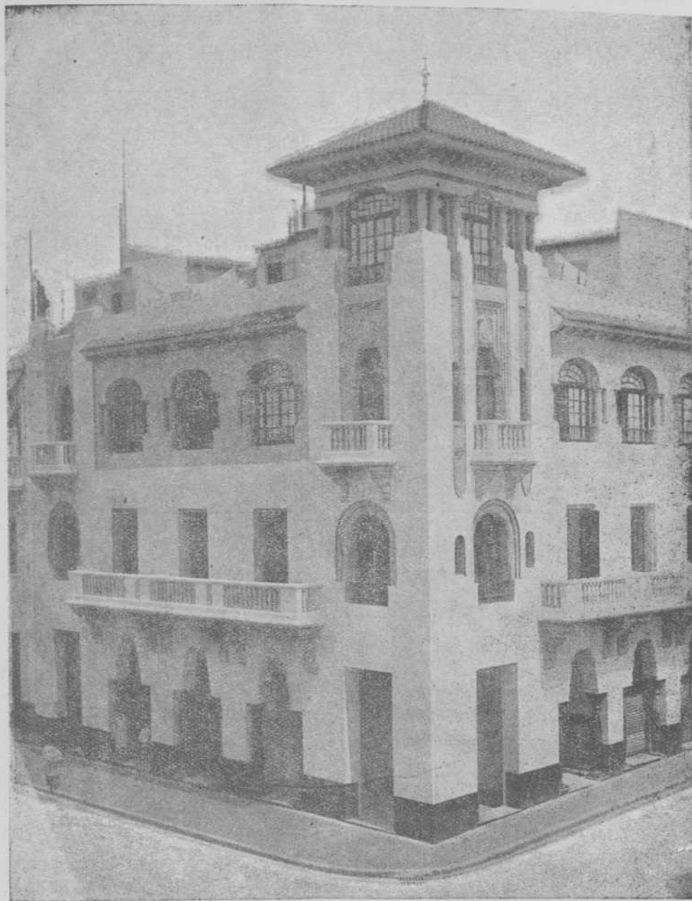
EDIFICIO PROPIEDAD DE DON FRANCISCO MIRANDA RUIZ, BELLO ORNATO DE LA AVENIDA GENERAL BARRERA
