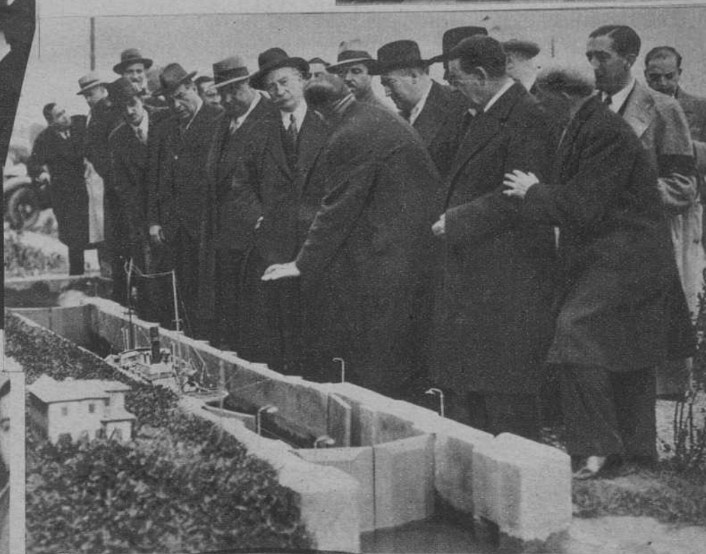
El señor Lerroux viendo la maqueta de la esclusa que cierra la dársena en las obras del canal. — (Fts. Sánchez del P.)
