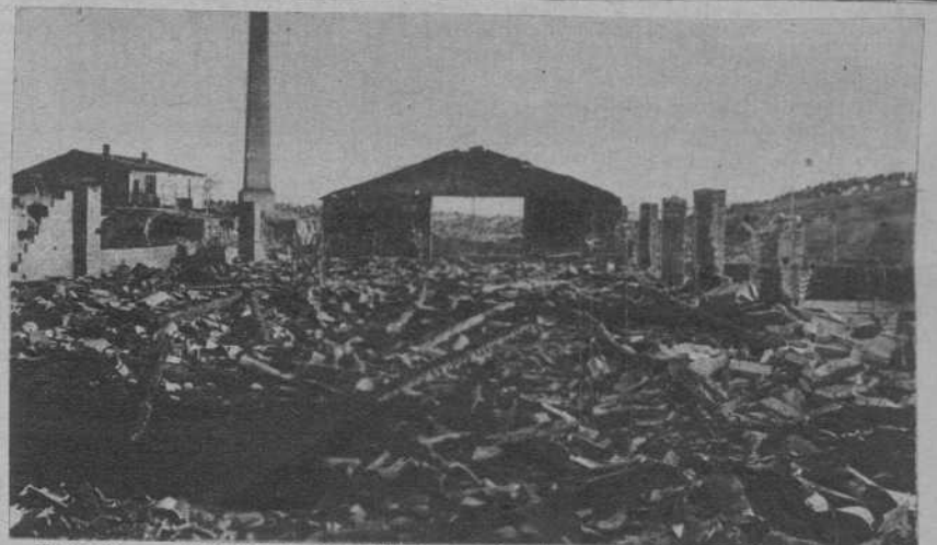
Tarrasa. — Dos vistas del edificio destinado a la elaboración de ladrillos, propiedad de la «Cooperativa Obrera La Fiel», que ha sido destruido por un incendio. — (Fot. Llobet)
