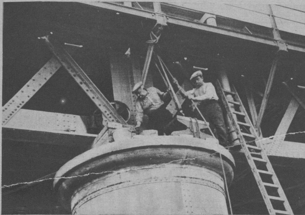
La reparación la determinó los destrozos causados por la explosión de una bomba hace algún tiempo (Fots. Badosa)
