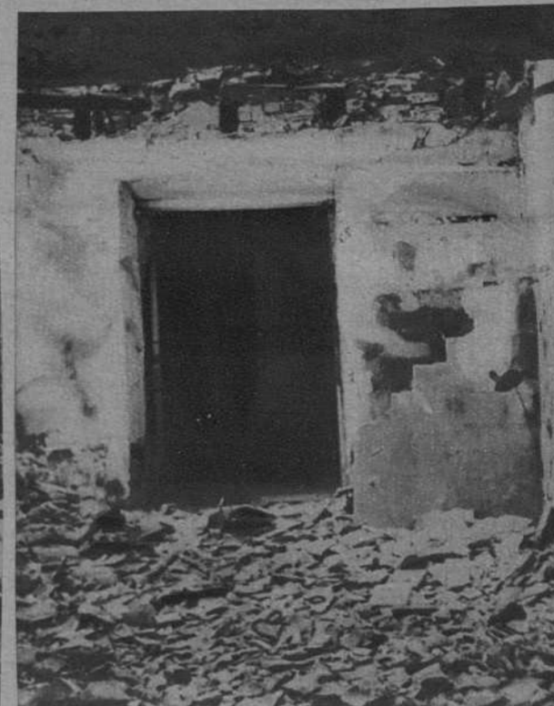
Puerta de comunicación de la iglesia con la Rectoría. — (Fot. Dalmau)
