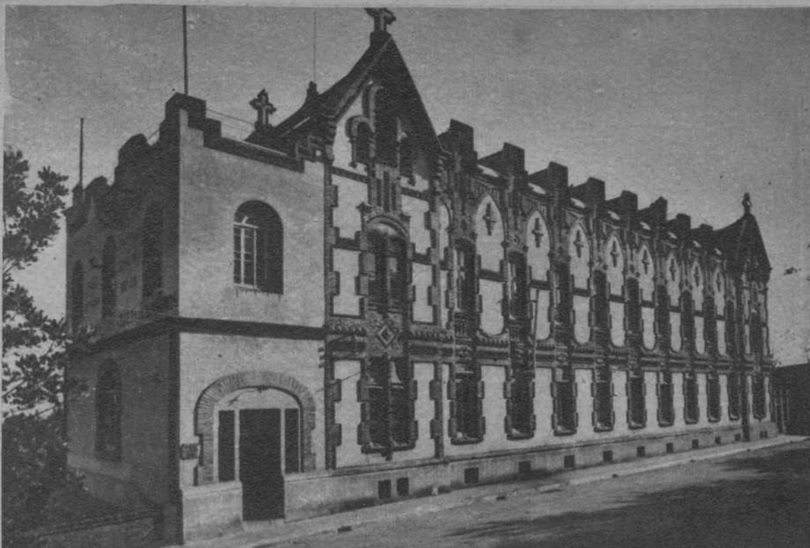
El edificio del Amparo de Santa Lucía, Casa de Familia para ciegas
