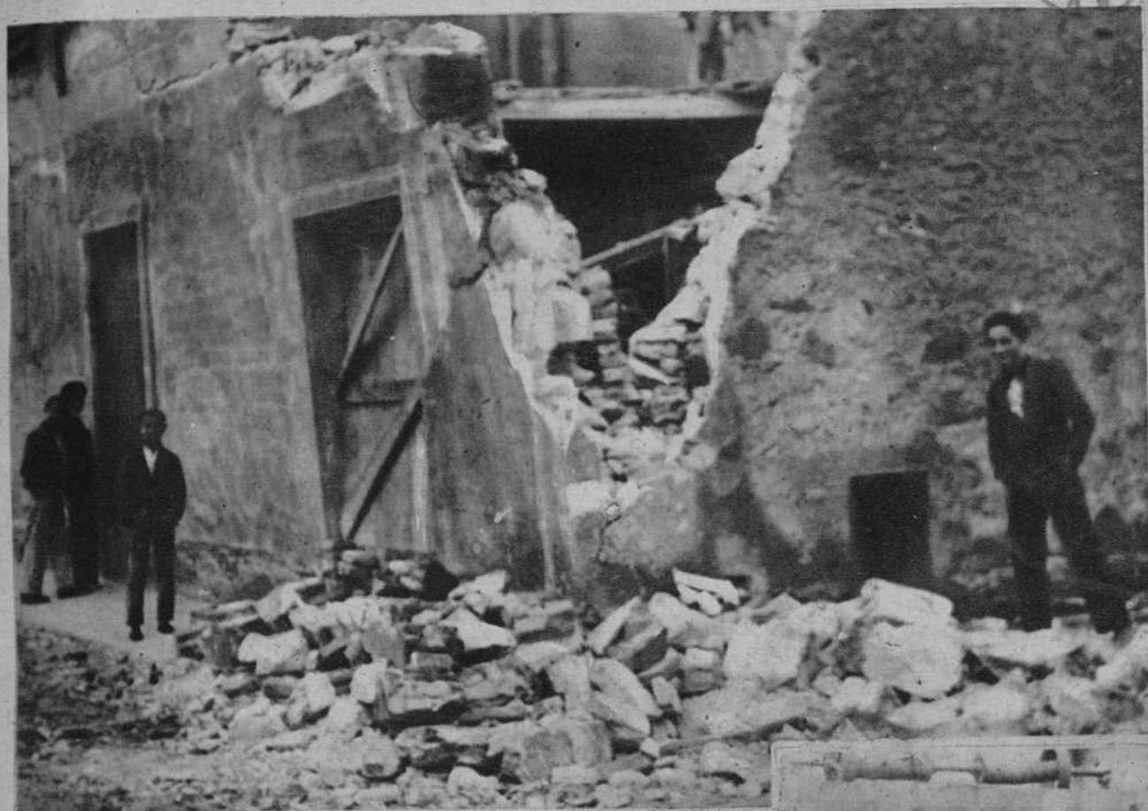
Pared derrumbada por la explosión en la Vidriera Badalonesa
