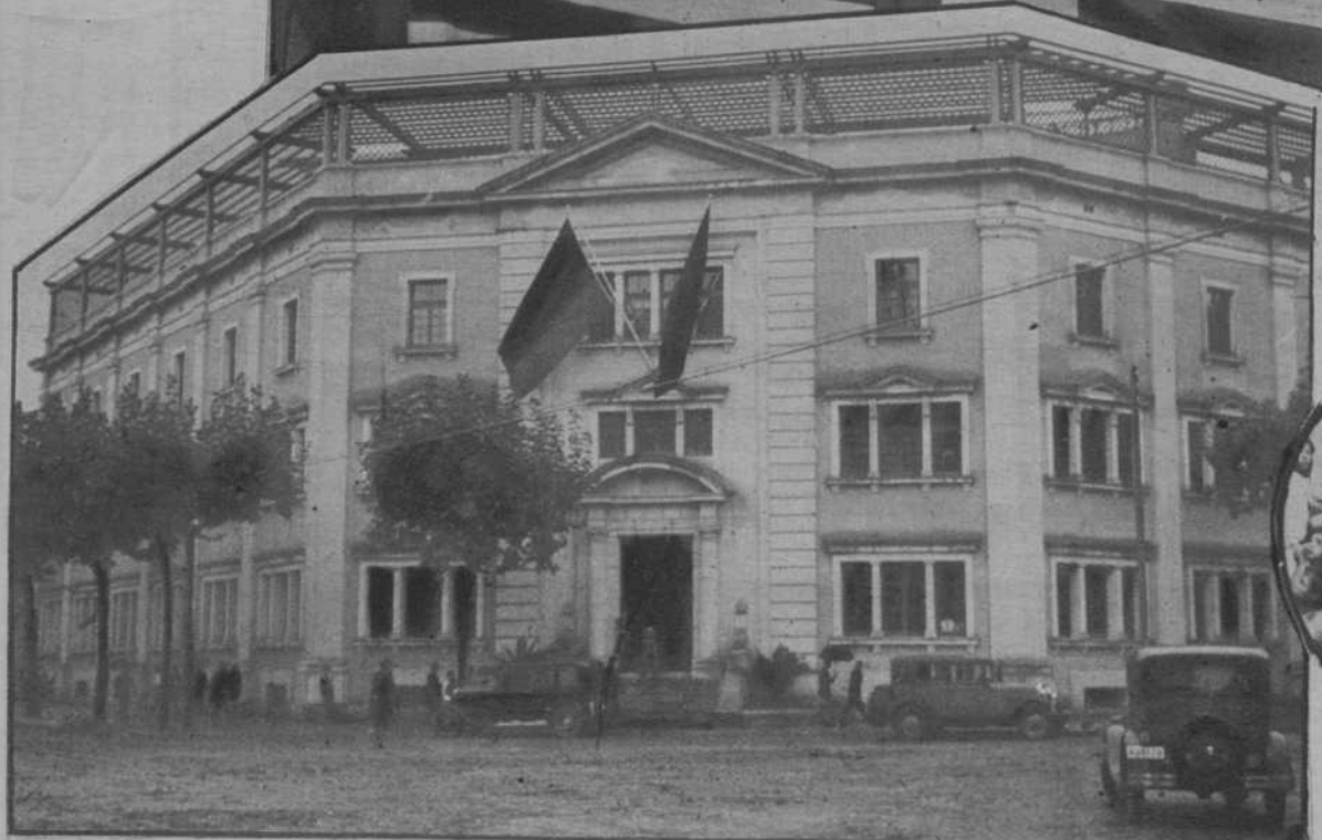
Edificio destinado a la Clínica, situada en la calle de Llull, chafán a la de Cerdeña (Fot. Pérez de Rozas)
