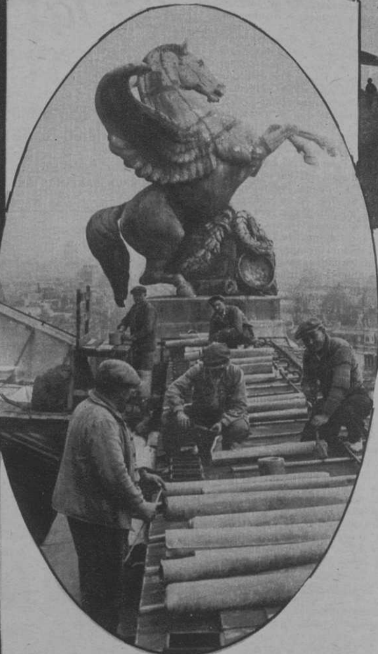
París.—La limpieza y renovación del edificio de la Ópera, lo pondrán como nuevo.— (Fot. Keystone)
