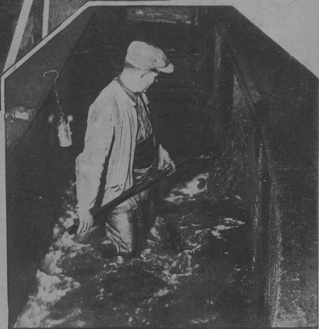
A veces, la corriente de la cloaca se obstruye, y un obrero, puestas las altas botas impermeables, quita los detritus acumulados
