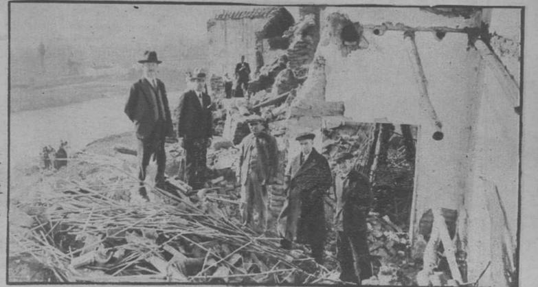
Una de las casas hundidas en Cantillana, a causa del corrimiento de tierra hacia el Guadalquivir. — (Fot. Sánchez del Pando)
