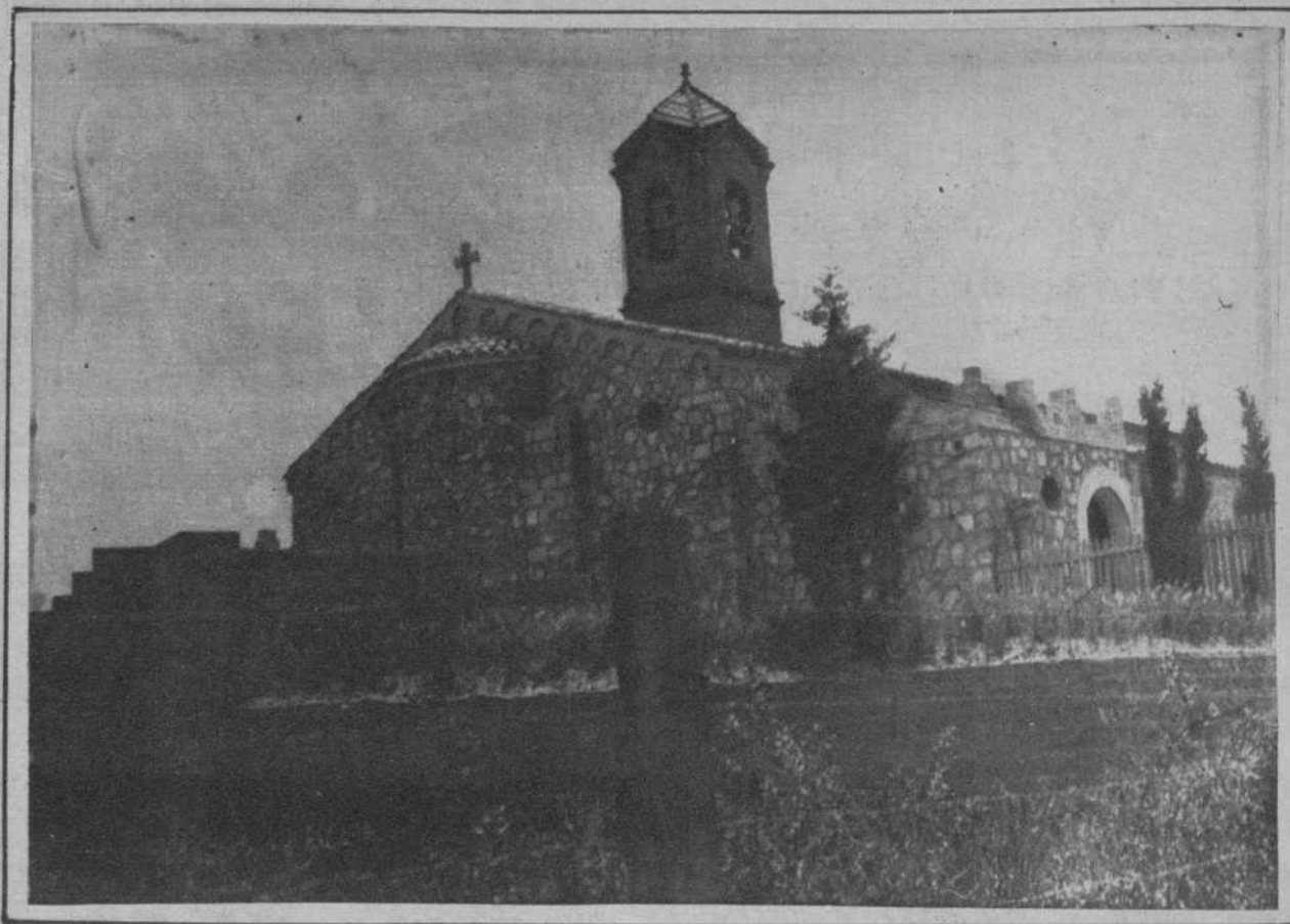
Vista general de la iglesia
