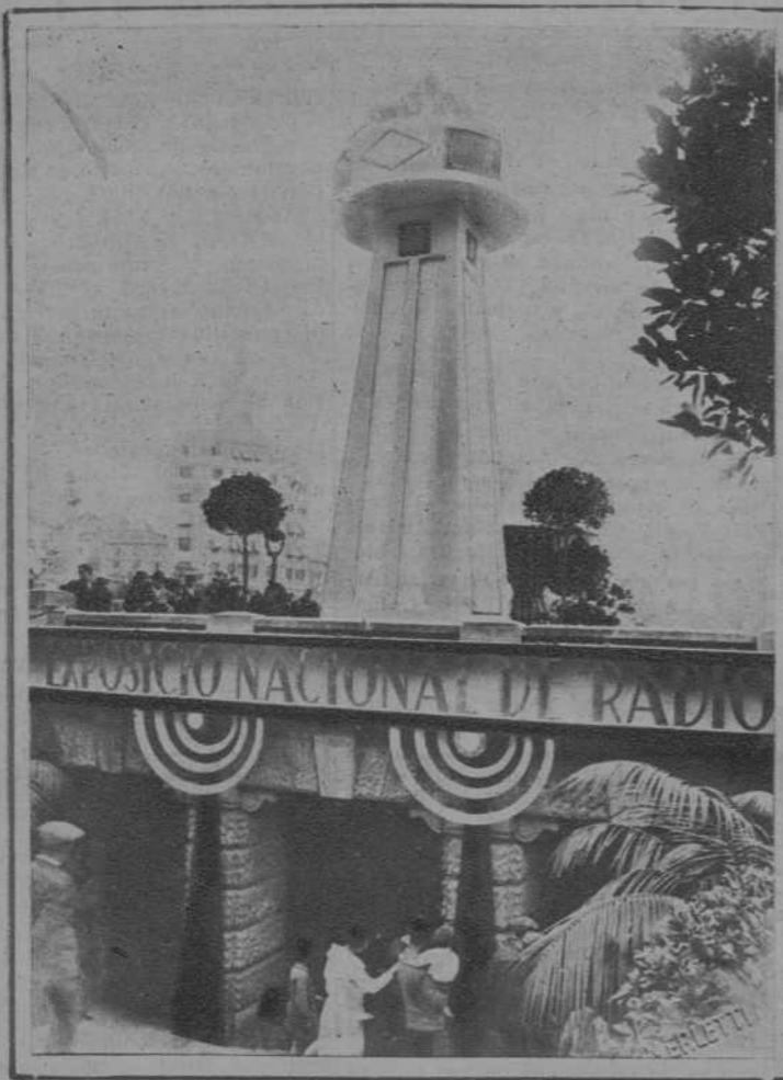
Artística y moderna puerta de acceso a la «1.ª Exposición Nacional de Radios», cuyo interesantísimo certamen está instalado en los locales subterráneos de la Plaza de Cataluña, fronteros a nuestra Redacción. — (Fot. Merletti)
