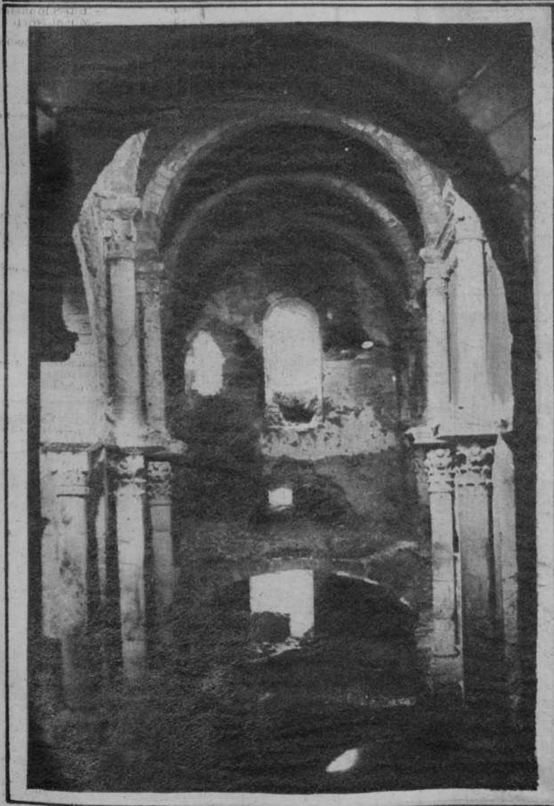
Interior del templo
