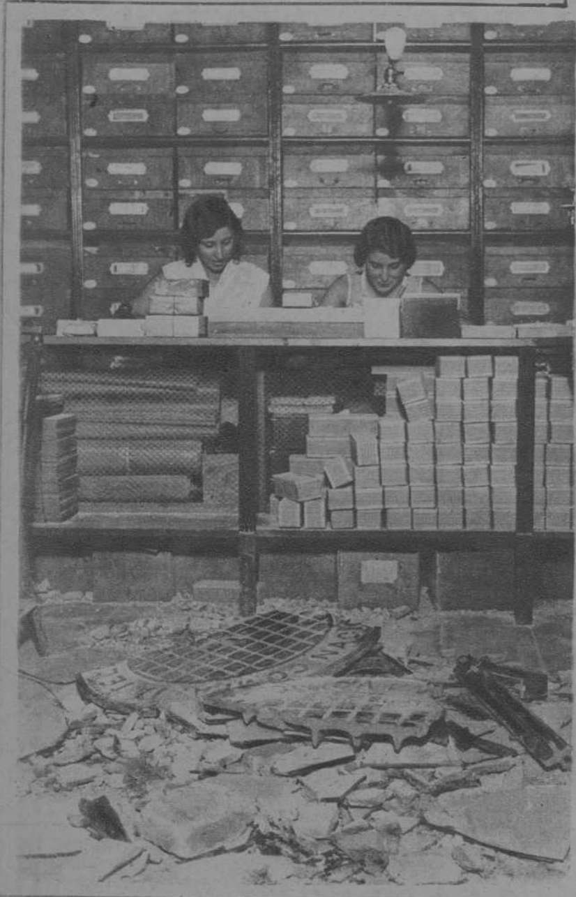
...y cayendo al interior de un establecimiento comercial instalado en los bajos de dicha casa. — (Fots. Badosa)
