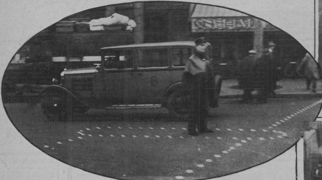
La circulación en París.—El pavimento de acero ha venido a reemplazar los clavos de cobre, que no resistían el peso de los vehículos.—(Fot. Keystone)
