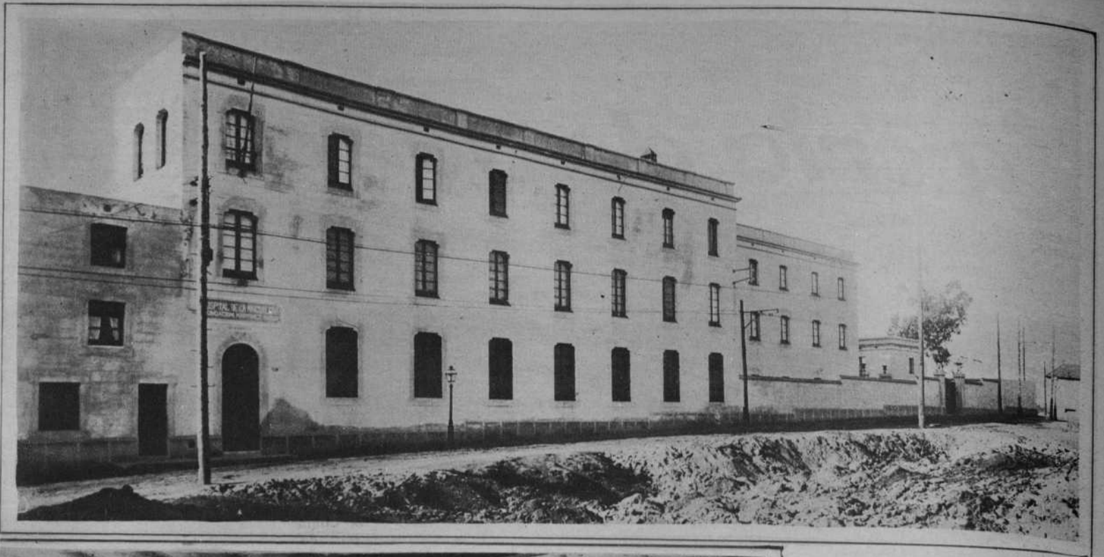
Vista general del Hospital de la Magdalena
