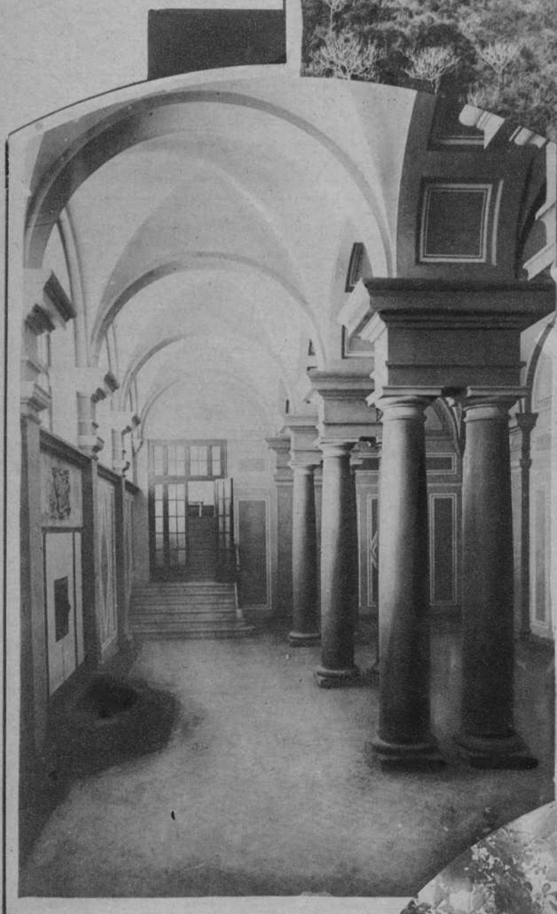
Aspecto parcial de la galería de las nuevas Escuelas de Cultura Popular de Sabadell
