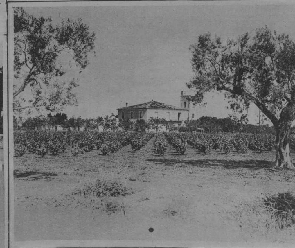
Villa Amparo, de 2.000 hanegadas, con pozo de 2.200 litros por minuto
