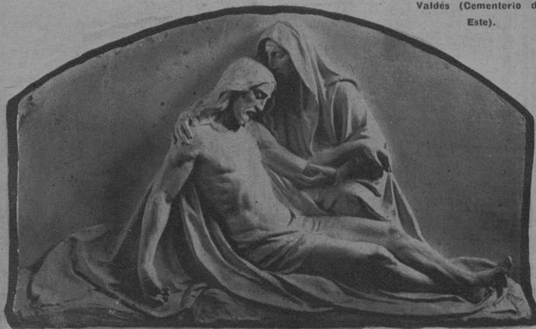
Fragmento de panteón en construcción.
