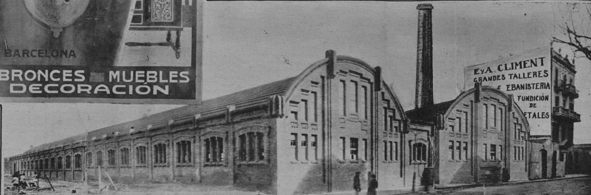
Vista panorámica de sus nuevos talleres, que junto con los antiguos, situados al otro lado de su casa sede central que aparece a la derecha -destinado a Oficinas y Salas de Exposición ocupan por completo, la manzana delimitada por las calles Condes de Bell-Lloch, Viriato, Puiggari y Provenza.
