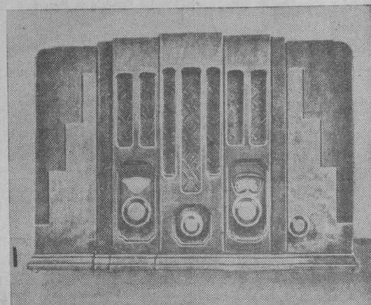
Un superheterodino RCA de 5 válvulas, presentado en un mueble de dos tonos, que contiene el chasis y el altavoz dinámico de 12,5 centímetros de diámetro. Demostraciones en S. I. C. E., E. Dato, 9.
