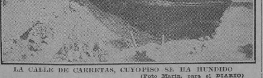
LA CALLE DE CARRETAS, CUYO PISO SE HA HUNDIDO (Foto Marín, para el DIARIO)
