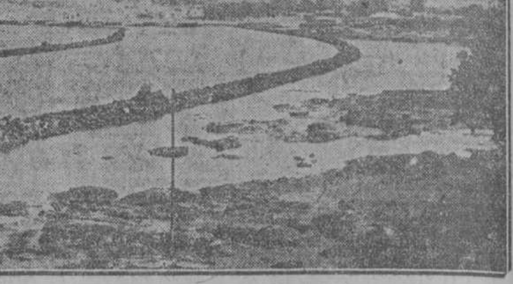
Vista de Pontevedra y las obras de canalización del río Miño.
