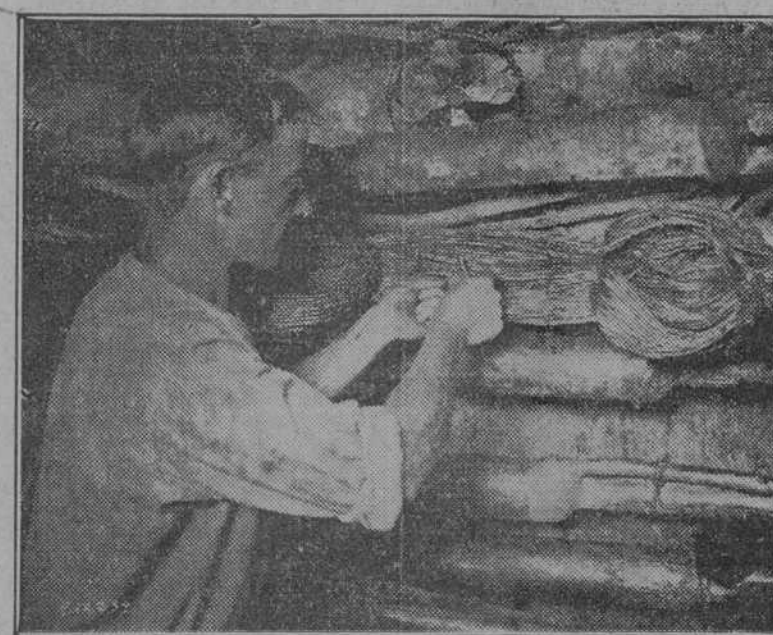
Empataador, Charles A. Mc Clafferty, empataando cables en la calle de Aguilá.
