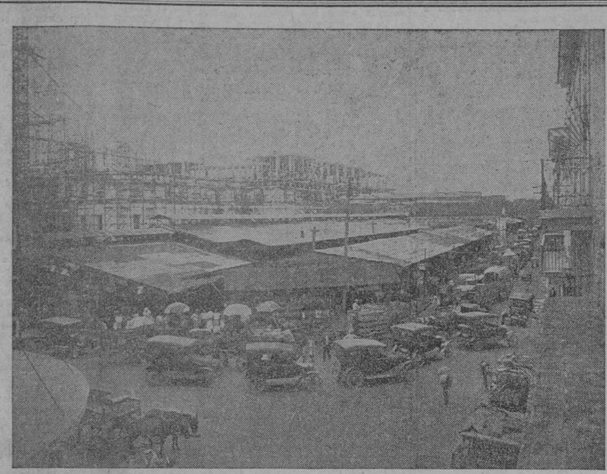
El mercado de Villanueva que ayer quedó clausurado y cuya demolición comenzará hoy. Dicho mercado fue establecido con carácter provisional al clausurarse el mercado de Tacón en primero de julio de 1918.
