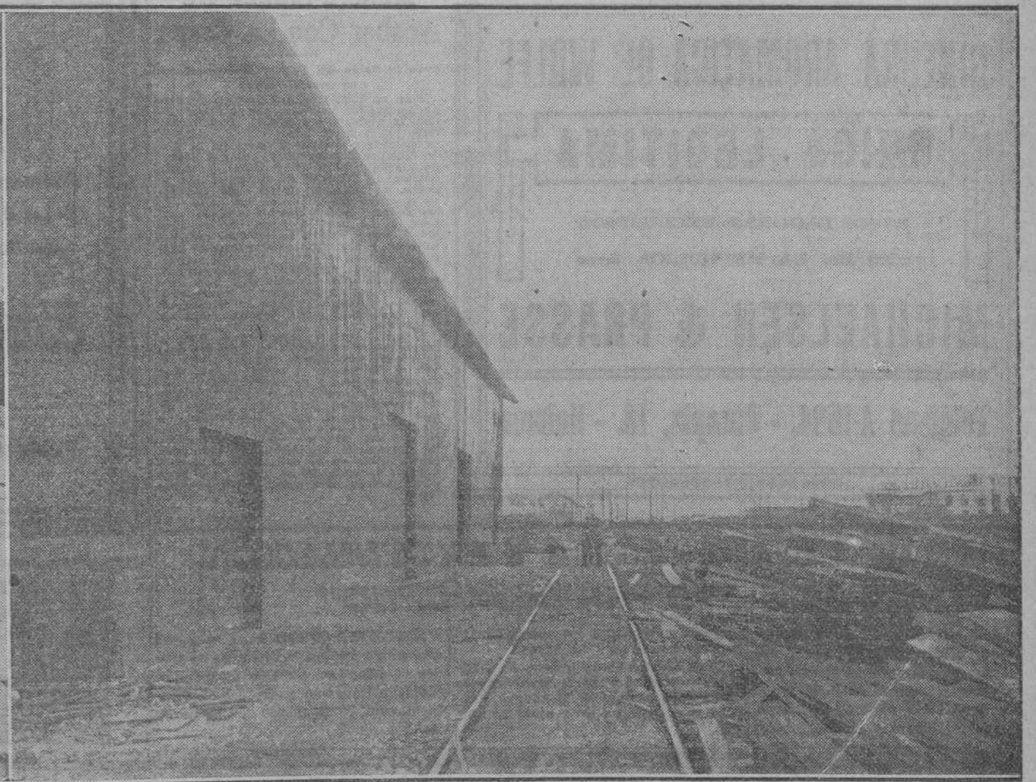
OTRO DE LOS ALMACENES SITUADO EN ATARES, CON CHUCHO PROPIO PARA EMBARQUES
