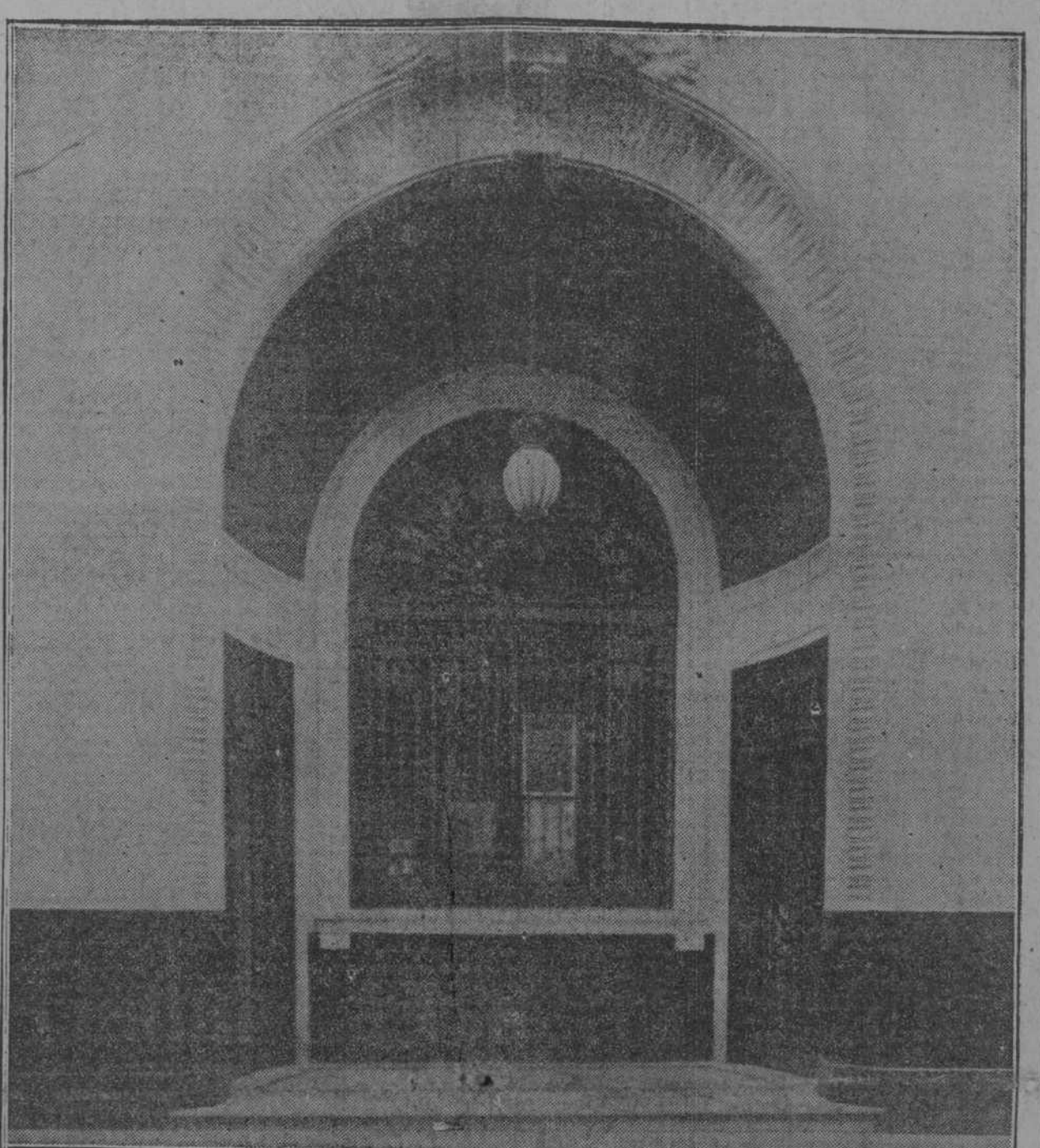
La gran portada del nuevo edificio de la firma Carrillo y Forcade, de la que, en la página nueve, damos una detallada información. Este edificio se eleva en el número 36 de la calle Obispo y ha sido construido bajo la dirección de los arquitectos señores Morales y Co.
