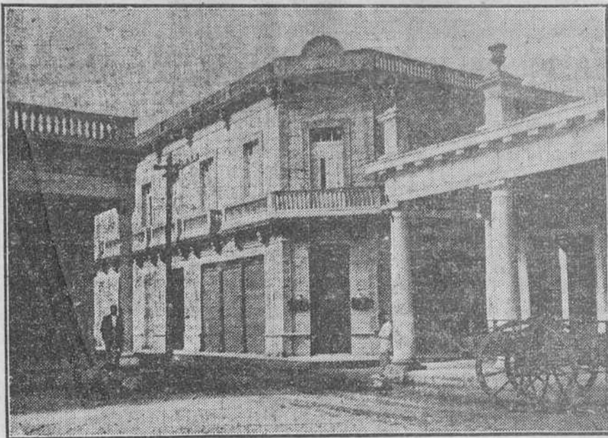
Las ciudades del interior.—Espléndido edificio, propiedad del doctor Rodolfo Socarrás, en cuyos bajos está instalado la sucursal del Banco Español.
