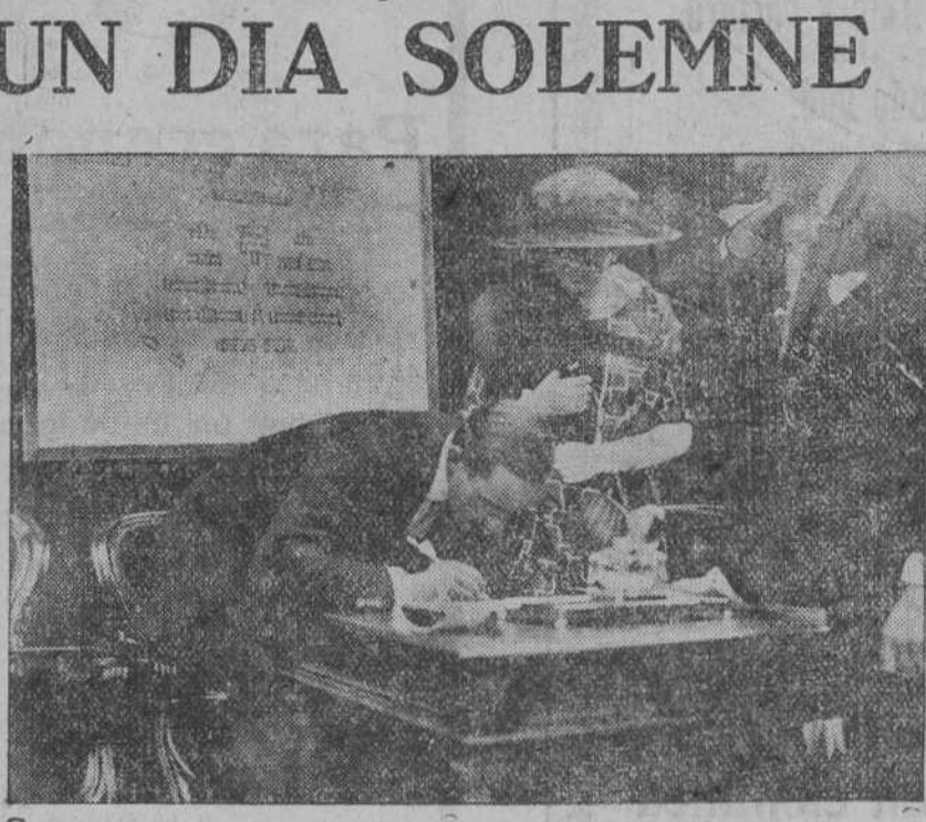
El Rey firmando el acta de colocación de la primera piedra del nuevo Hospital el día 26 de agosto de 1920. (Foto Samot.)
