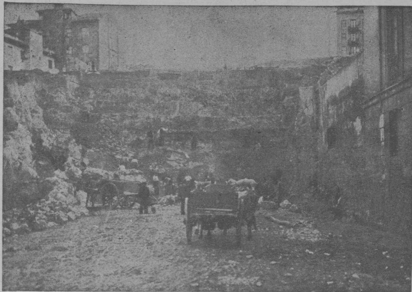
Estado actual de las obras del Tunnel del Pueblo, donde, según la referencia de la Alcaldía, dentro de pocos días se colocará la primera piedra con asistencia de las autoridades.—(Foto Alejandro)
