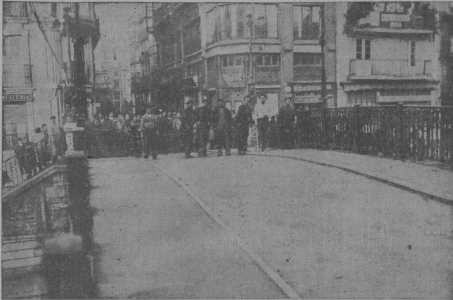
En el día de ayer ha comenzado a desmontarse el puente de Vargas. Una vez desmontado, el Ayuntamiento terminará la obra con un bonito y cómodo proyecto de rampas y escaleras que permitirán una fácil circulación hacia los sectores que antes dio comunicación este antiguo puente sobre las Atarazanas.—(Foto Alejandro)
