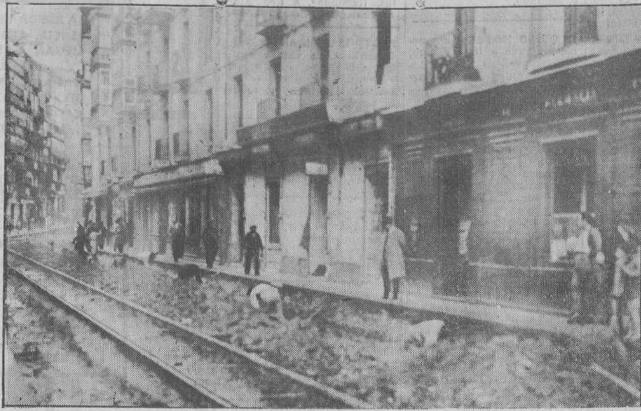
Las obras de reparación en la calle de Atarazanas. Dentro de poco, la que constituía uno de los más destacados barrizales de Santander quedará convertida en una vía decorosa. Pero el Ayuntamiento no debe guardarse aquí. El sistema debe alcanzar a tantas otras calles de la ciudad que están pidiendo por las mil bocas de sus buches la brigada de obreros que las transforme en vías de una población de importancia. (E. García Alvarez.)
