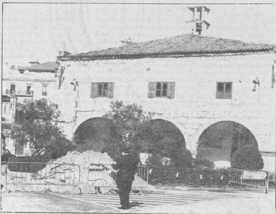
El socavón producido por estas obras, frente al Ayuntamiento laredano
