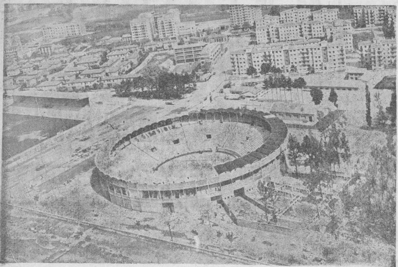
La plaza está completamente terminada y dispuesta para las fiestas de inauguración.
