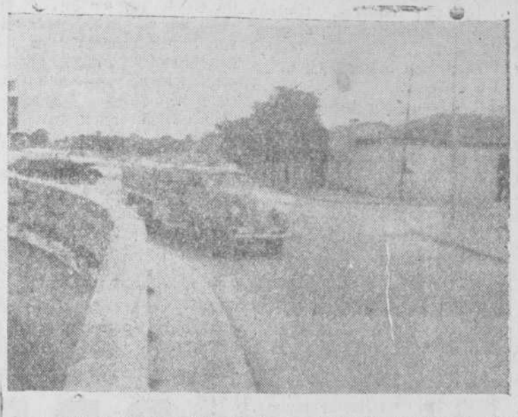
La amplia explanada del puente presenta sin embargo cuatro direcciones dobles, en las que se forman frecuentes aglomeraciones y se producen lamentables incidentes (Foto Guzmán Gombau.)
