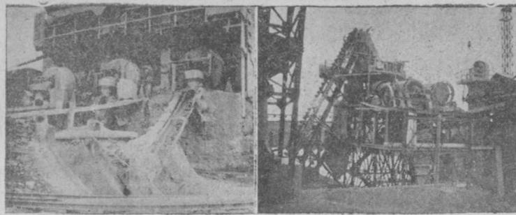
A la izquierda, las tres hormigoneras que surten de material a los distribuidores de balancín sobre la presa.—A la derecha, la complicada maquinaria en que en una sola serie se produce el hormigón, a través de esas cadenas de cangilones, depósitos y ruedas.
