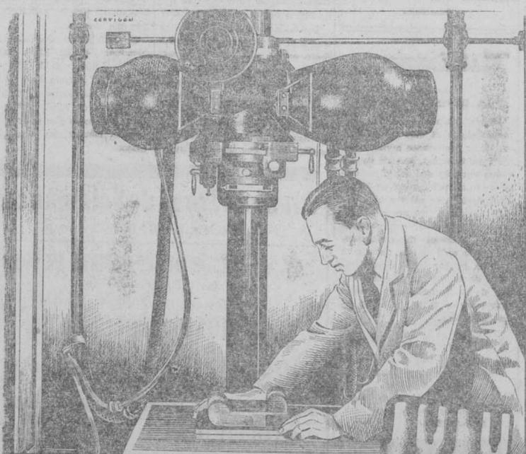
También el fundidor precisa de la fotografía... para radiografías que aseguren que las piezas fundidas no tienen defectos internos, evitando gastos de mecanización y fracasos de los que puede depender la vida de los automovilistas, aviadores, etc.
