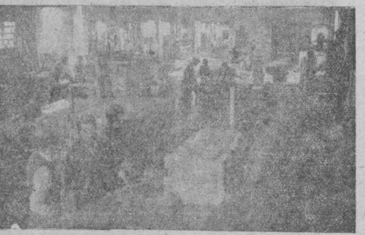
Una de las instalaciones. (Foto: Guzmán Gombau)
