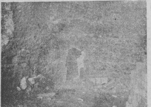
Uno de los hornos de cal, famosos en la comarca. Por la angosta entrada, se carga el horno que se cubre por su techumbre con bóveda para la cocción
