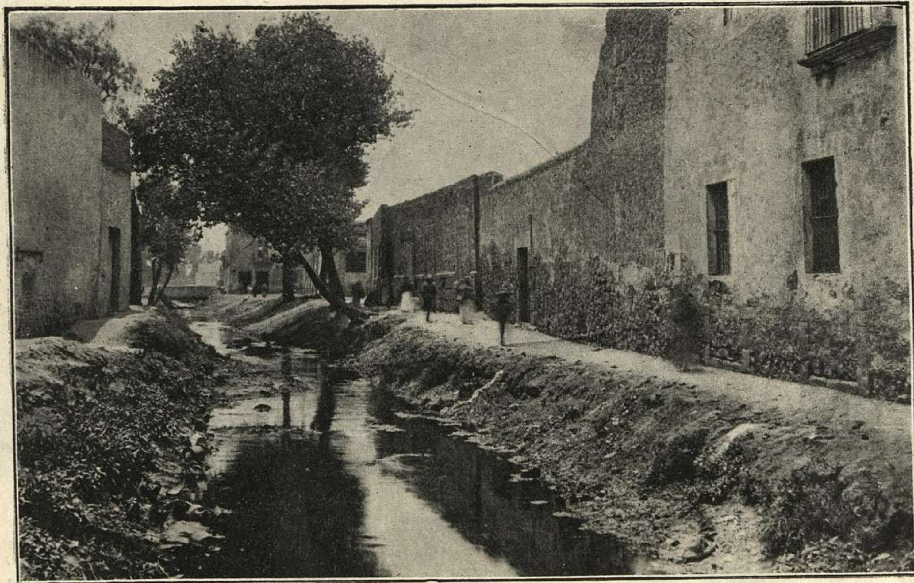
Calle del Olvido con el canal que deberá desaparecer.
