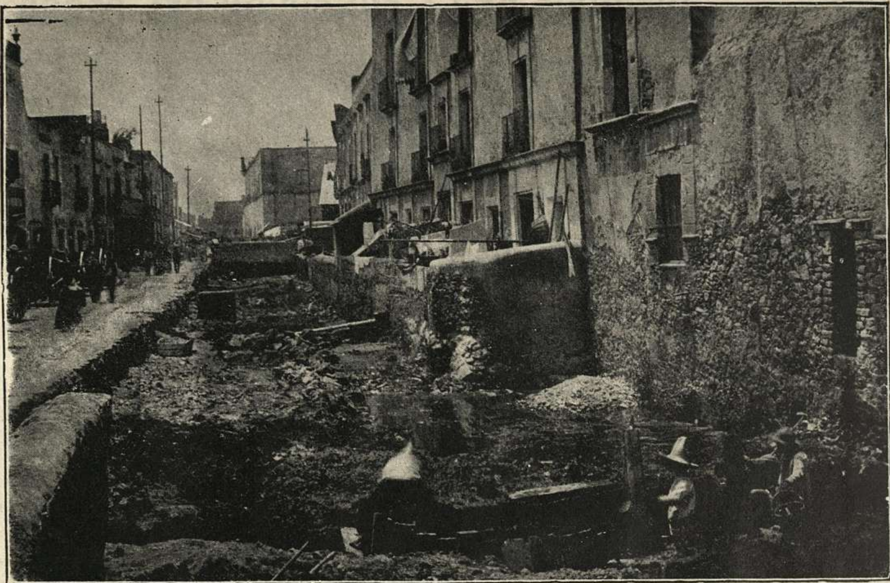
Los trabajos en la calle de Roldán.
