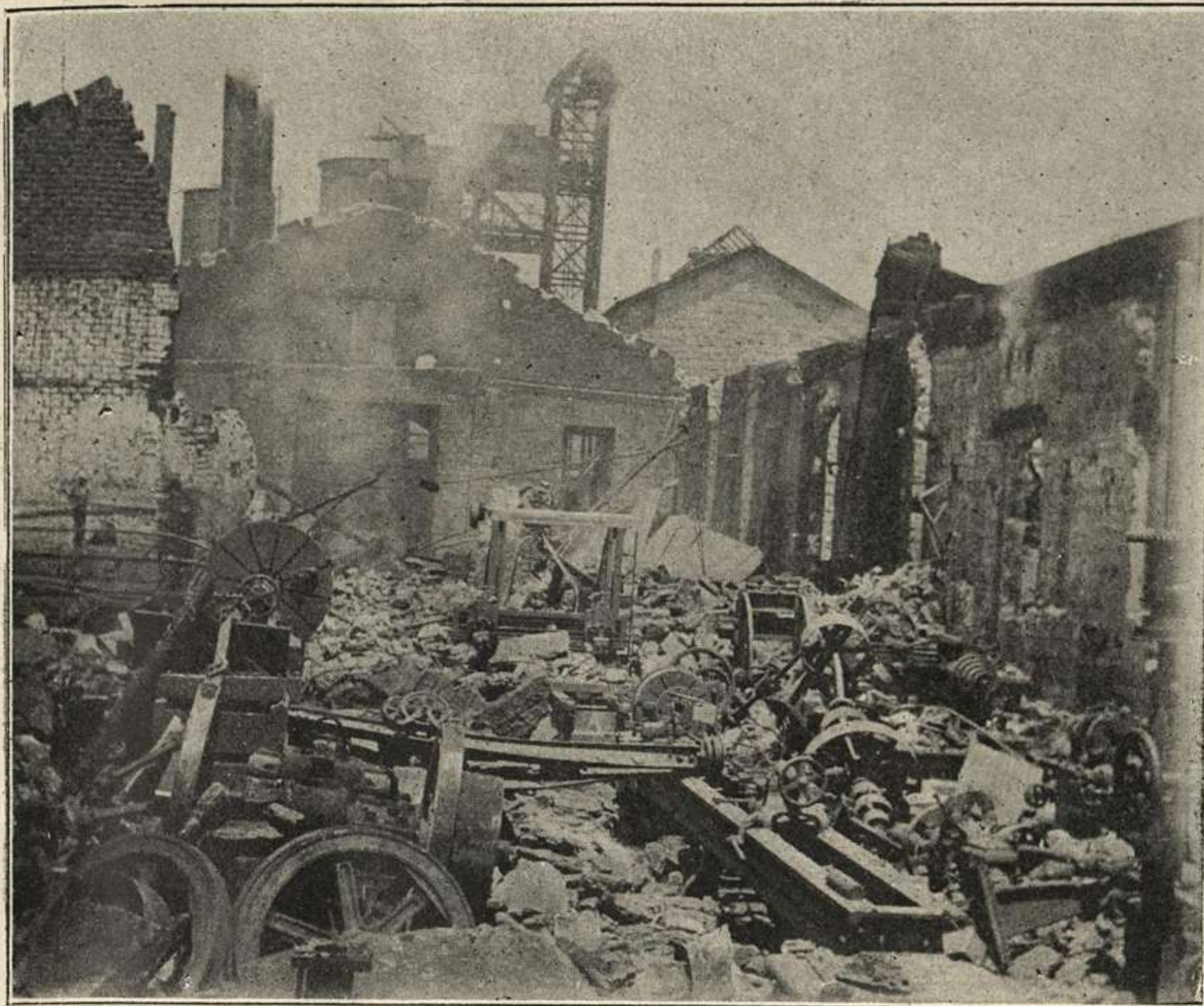
Interior del salón de máquinas, completamente destruido.
