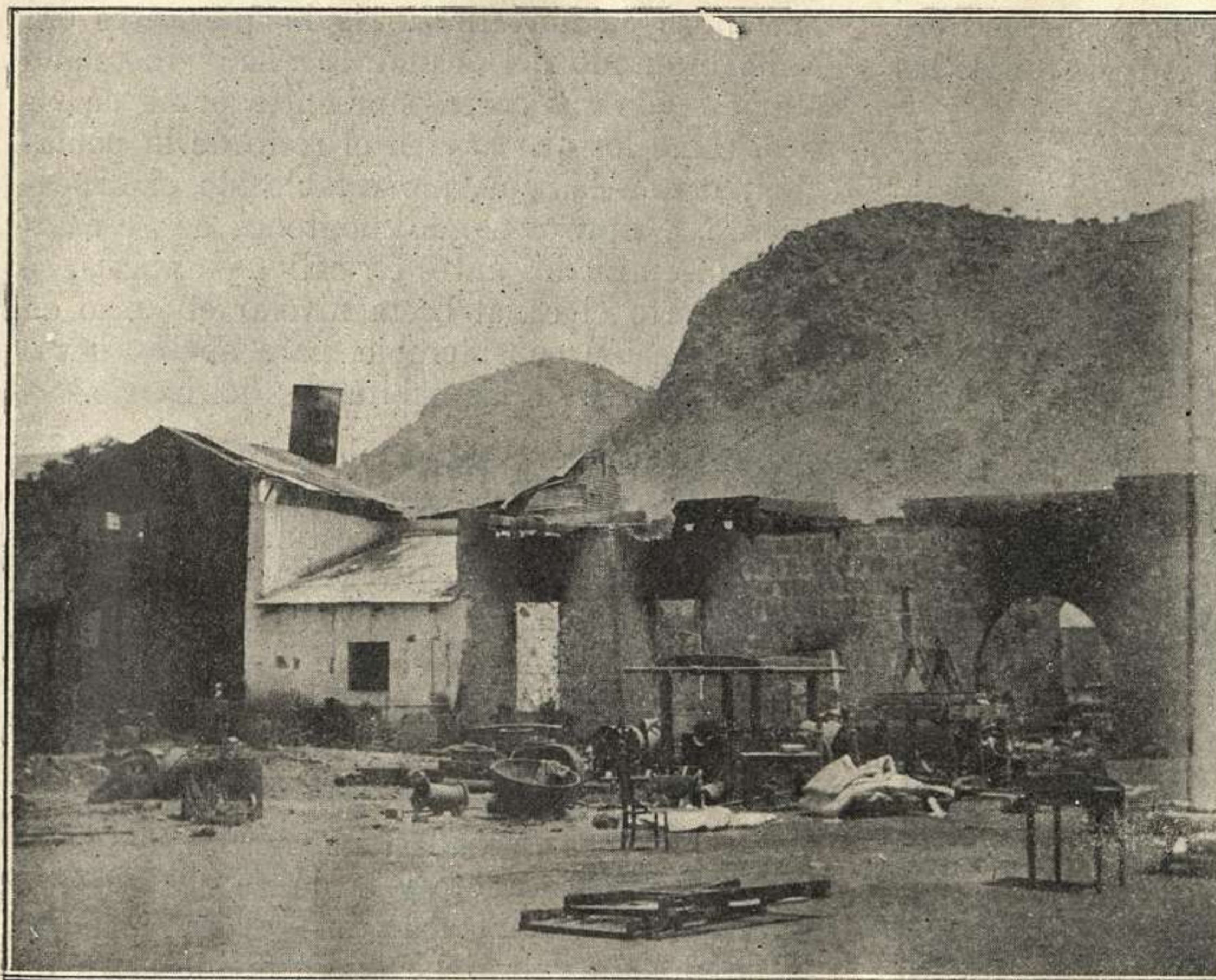
Exterior del salón de máquinas.
