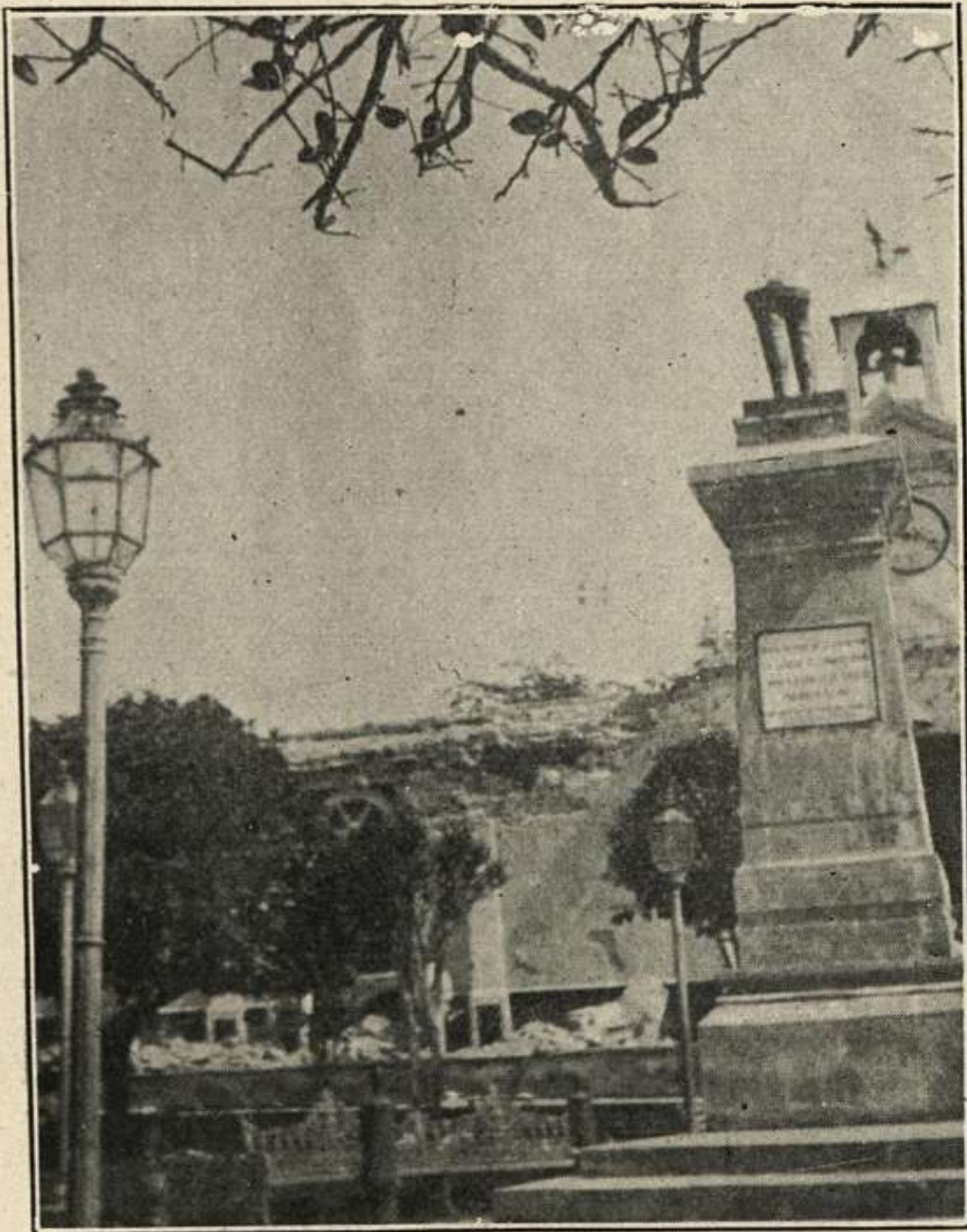
Estatua del Gral. Bravo y Palacio del Gobierno, destruidos.
