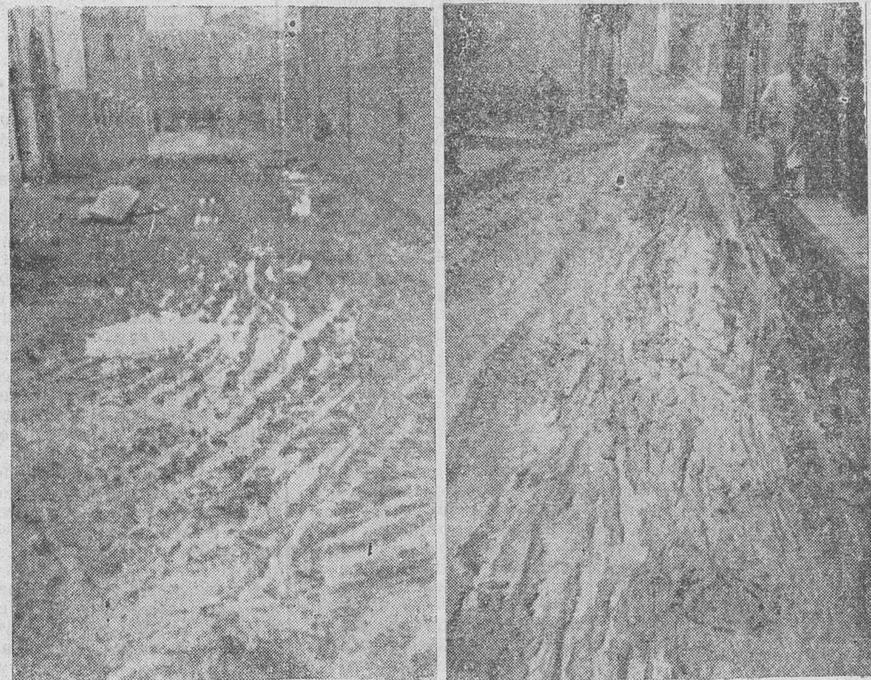
Izquierda: Zona de la Traviesa de San Marcos, a unos noventa metros de la calle del Generalísimo, en la que sólo unas piedras, pequeñas y en equilibrio inestable, hacen al peatón convertirse en un «estratega» o en un artista de circo.— Derecha: Lodazal o «chocolatería» de Ramos del Manzano, en un día del reciente descanso del temporal de lluvias, en que aún existe la posibilidad de caminar por las aceras, aunque no de atravesar «fácilmente» la calle.
