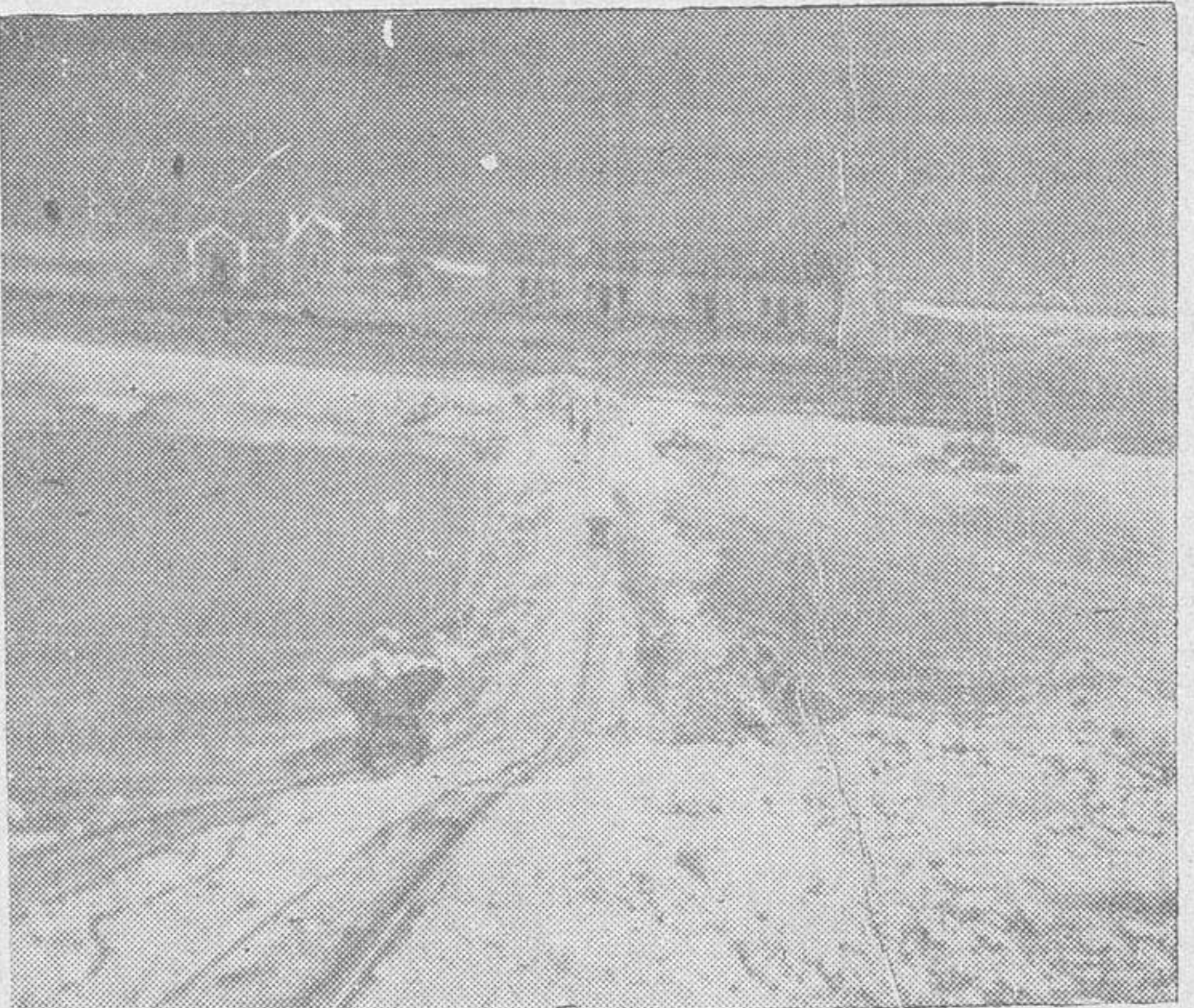
Desde la cantera a la estación de Arapiles, las vagonetas llevan la piedra por un rampa de 150 metros (Foto A. Gombau.)
