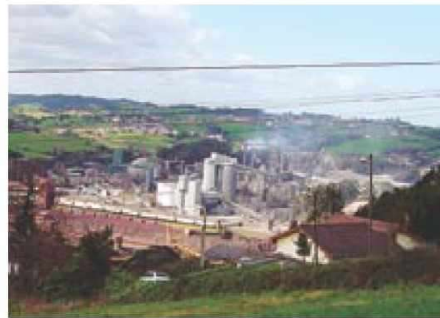
Las cementeras son unas buenas candidatas para la incineración de residuos industriales.
