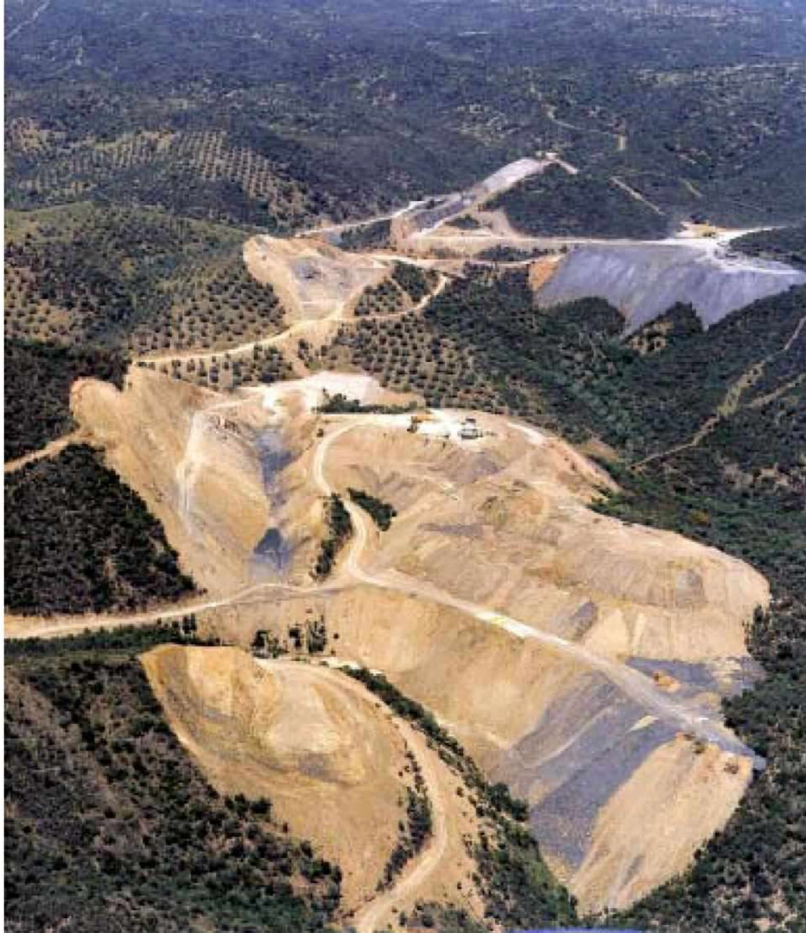
Cuesta creer que las redes de transporte transeuropeas sean beneficiosas para el medio ambiente, como afirman los documentos oficiales. Obras en la línea de AVE Madrid-Sevilla.
