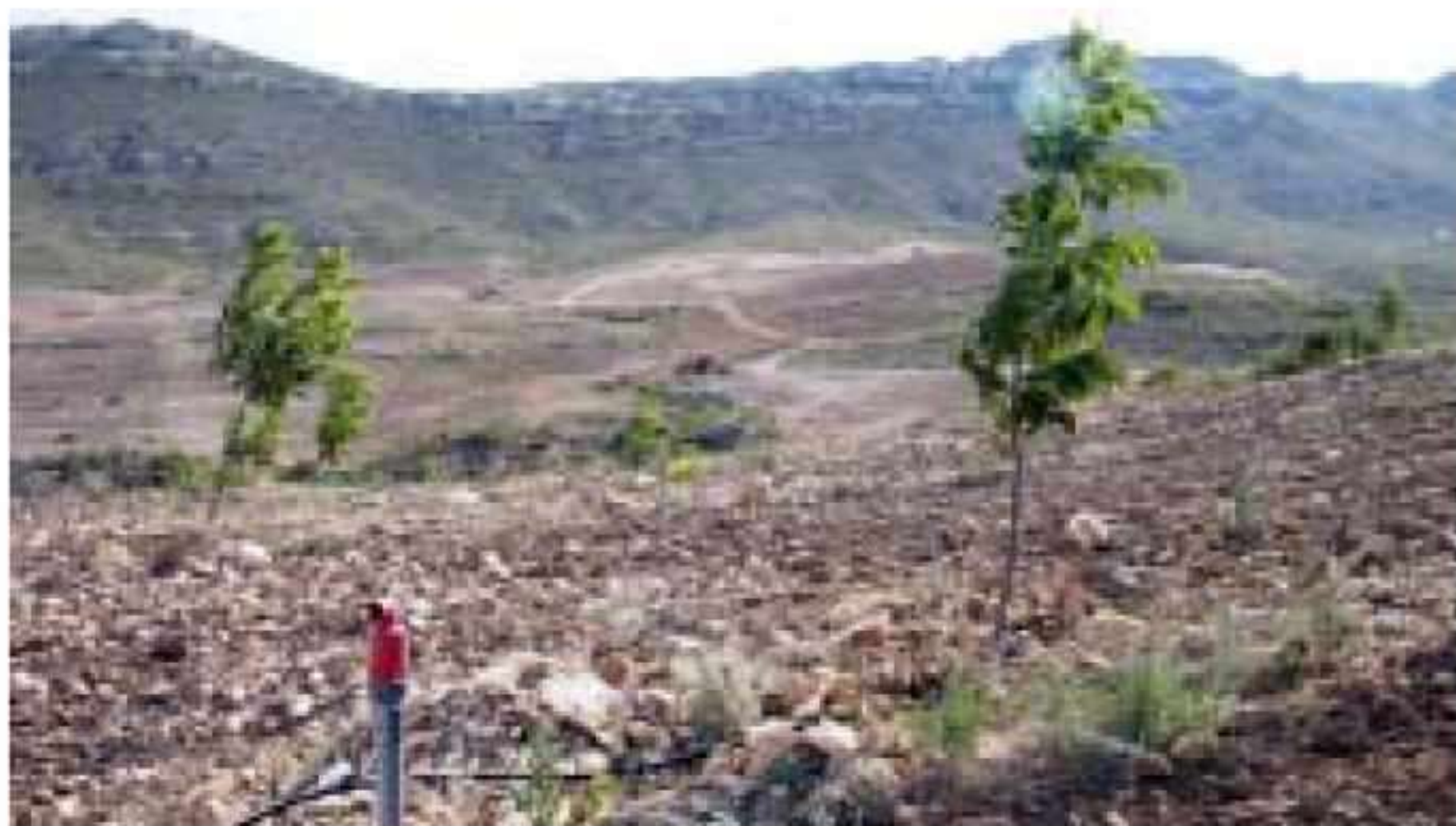
Nogales, gomas de goteo y válvula para purgar el aire de las tuberías. Al fondo maquina roturando. FOTO: WWW.PORTAL-AGUA.COM
