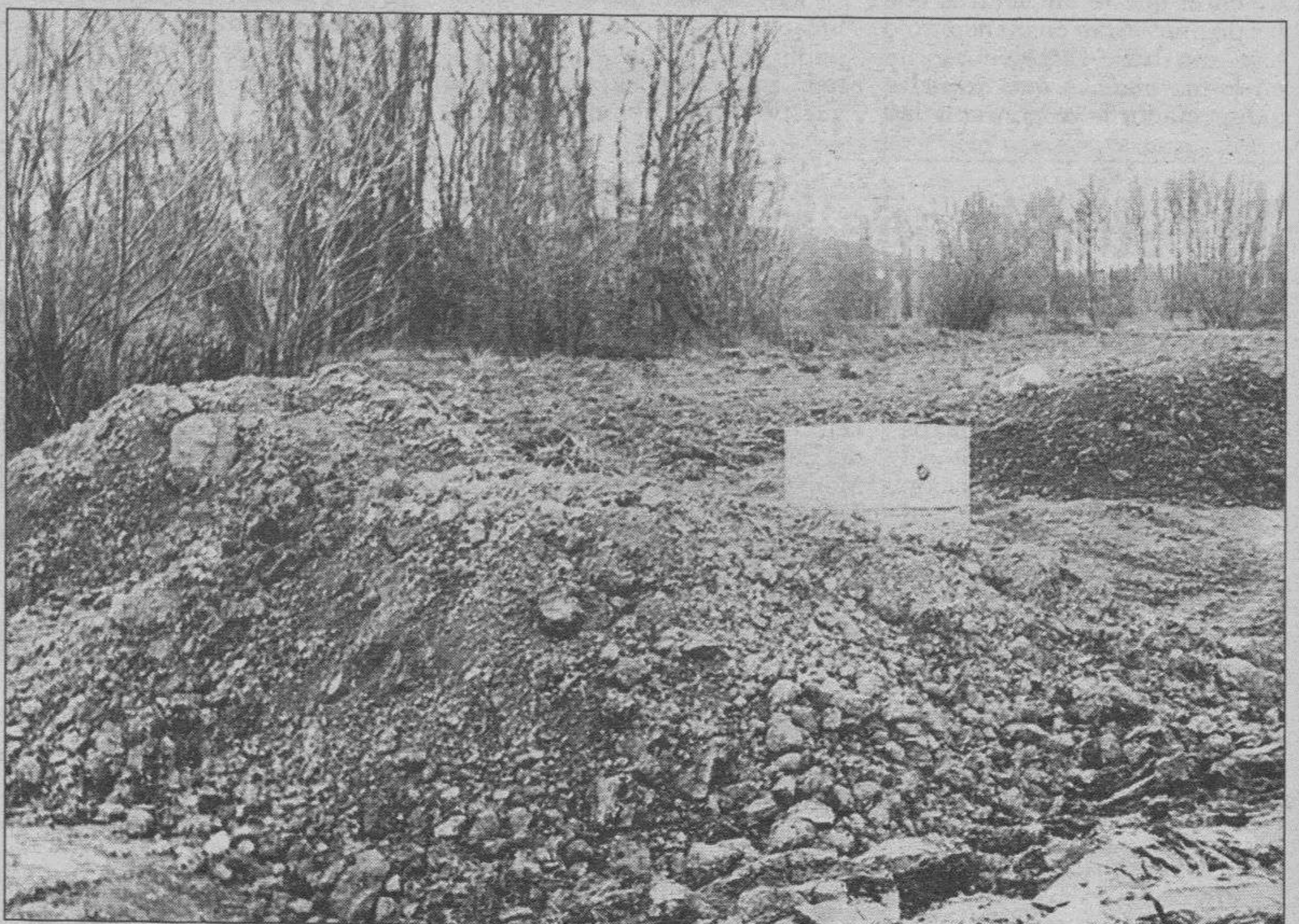
MONTEJO Las obras, que llevan paralizadas desde hace diez meses, se reiniciarán la próxima semana.
