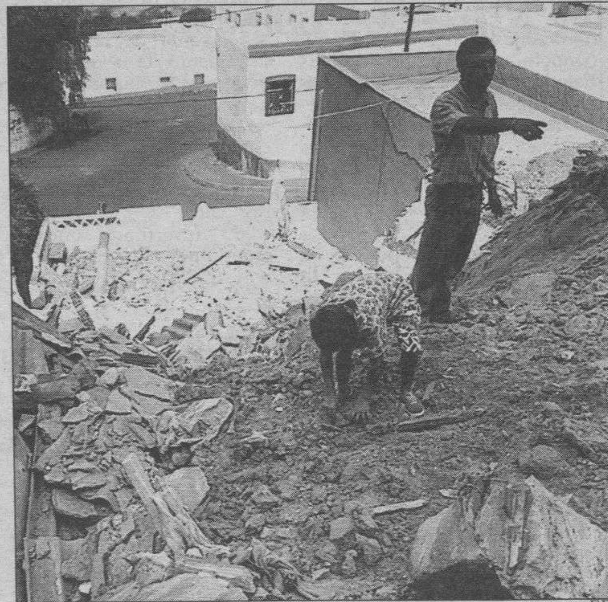
Restos de las dos viviendas derruidas en Almería.
