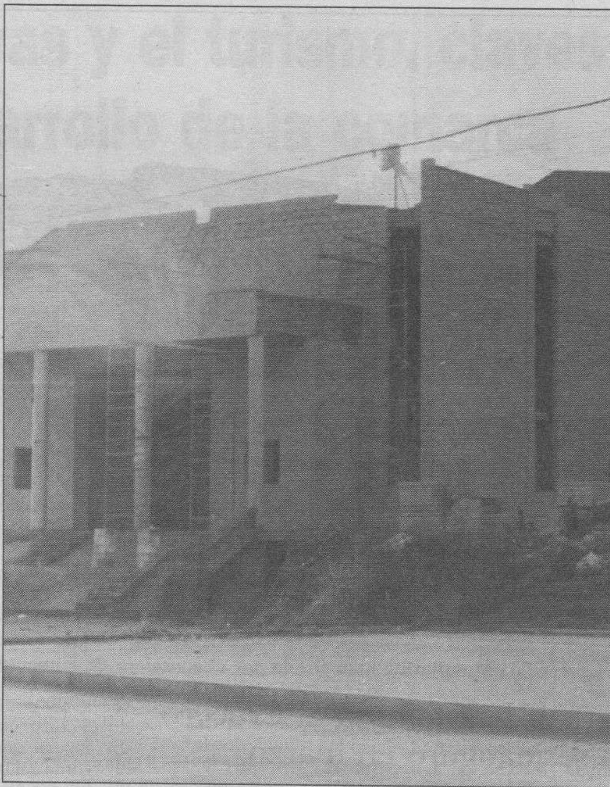
Las obras del polideportivo continúan sin finalizar tras ocho años.
