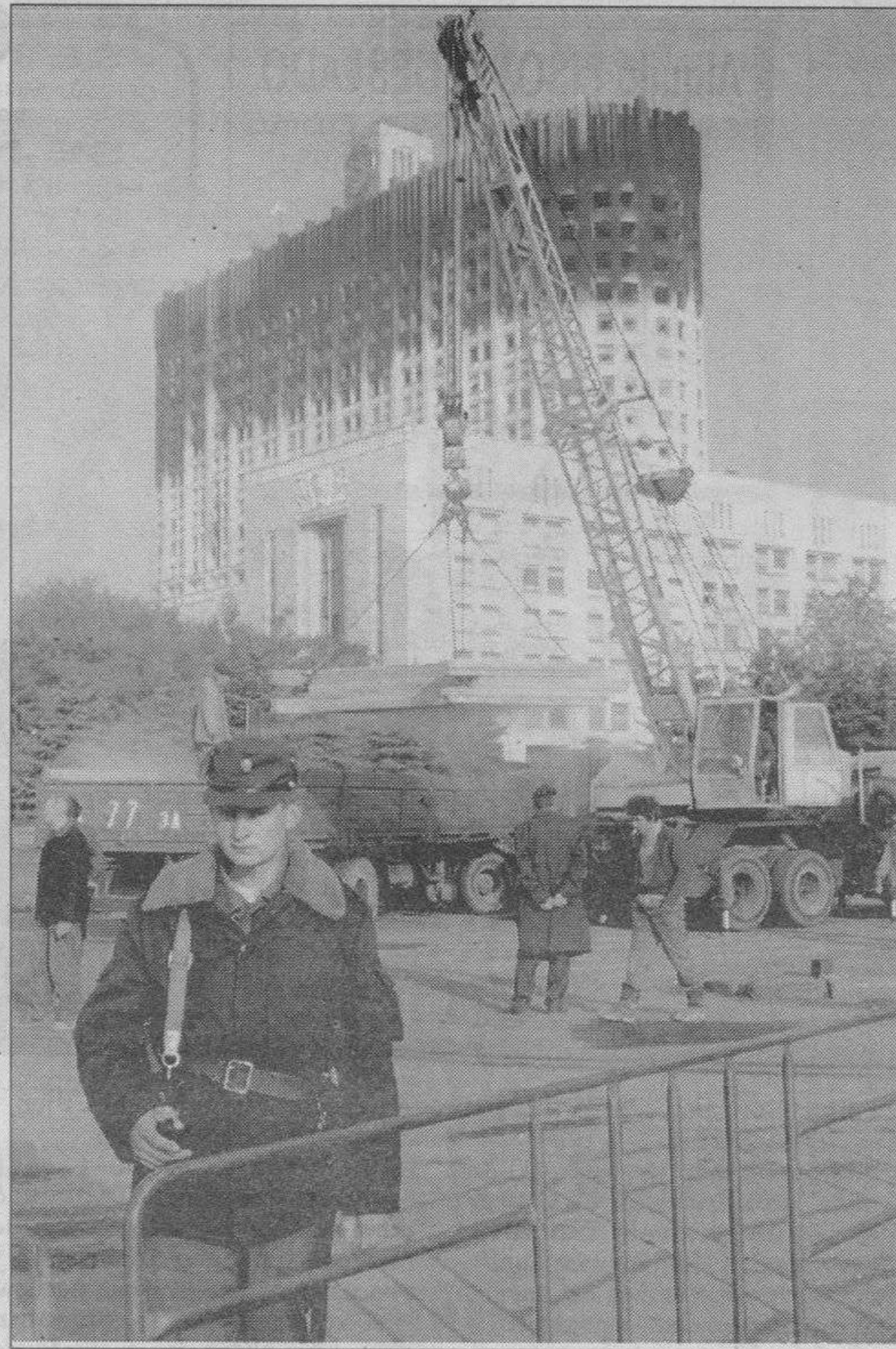
Desescombro en los alrededores de la «Casa Blanca».
