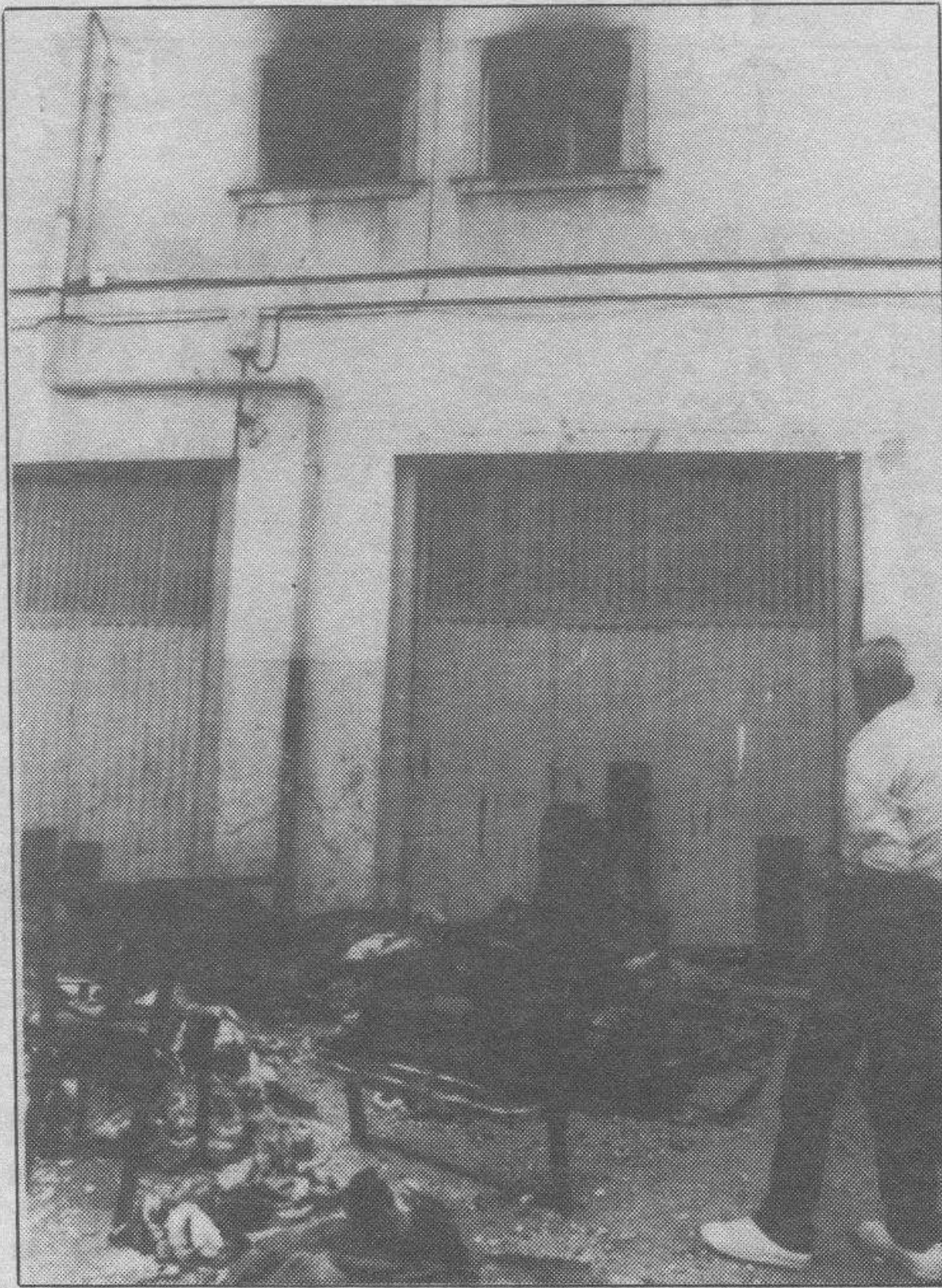
Ventana por donde fueron arrojados muebles y enseres.
